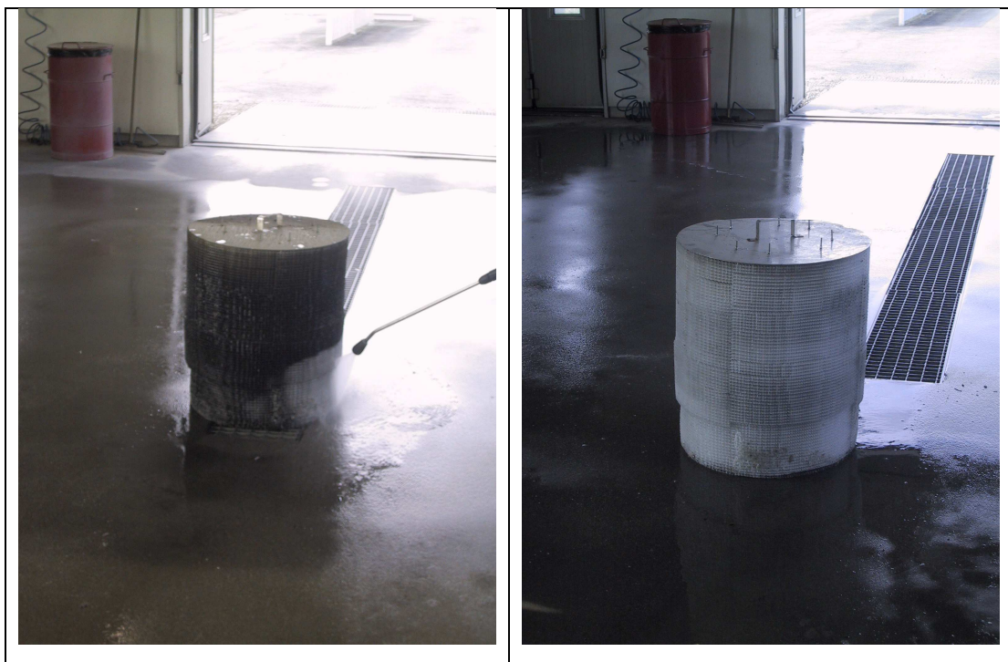
Kuva 8. Koalisaattorin puhdistus painepesurilla ja koalisaattori puhdistuksen jälkeen.
